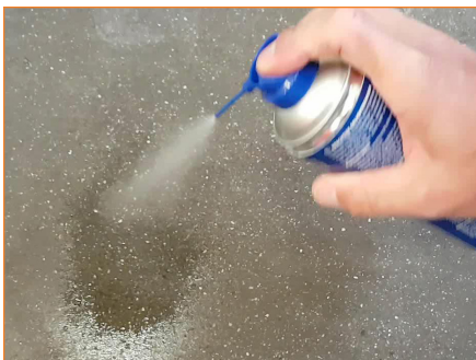
Vloer vetvrij maken met industriële ontvetter
